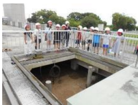
南部浄化センター
