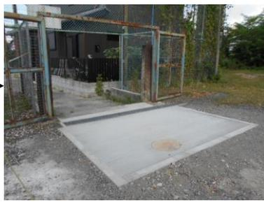
青門周辺の砂利が、側溝のグレーチングの隙間に落ちたり、雨天時には門扉から外に流れ出したりしていたため、舗装していただきました。
