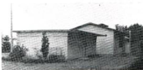
倉庫と給食室
