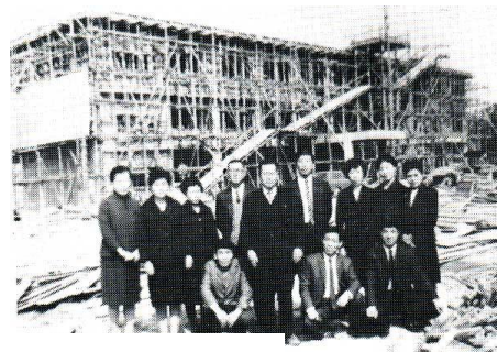
建設中の新校舎
